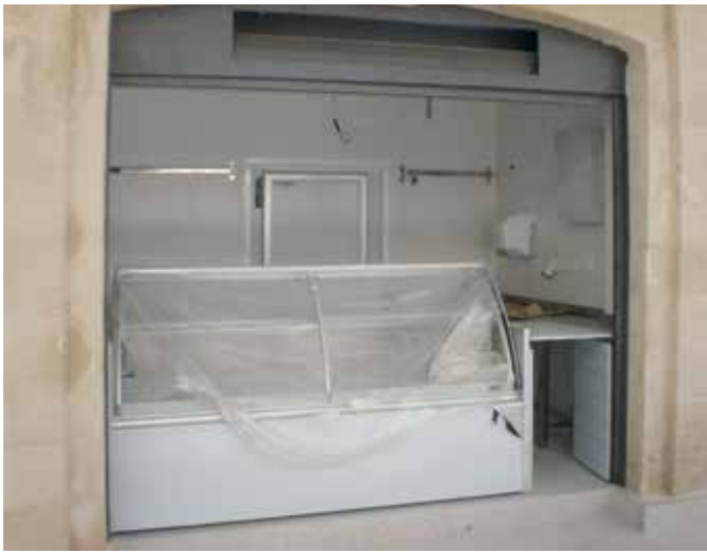
Cámara encastrada en obra Recessed cold room
